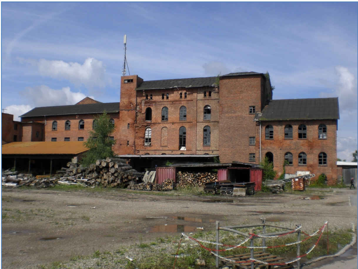
Abb. 11: Kali-Schacht Desdemona heute (IfSK).
